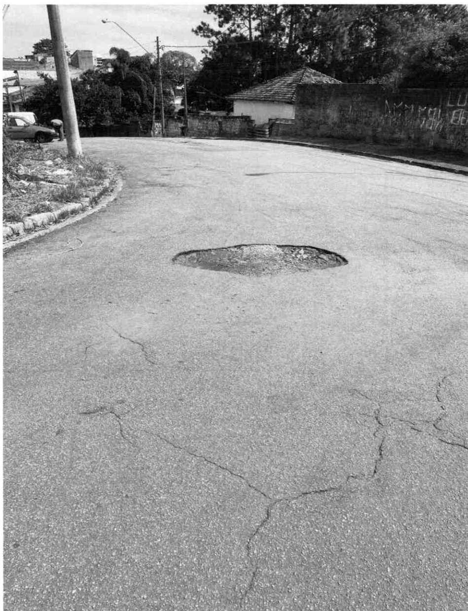
MANUTENÇÃO ASFÁLTICA EM TODA A EXTENSÃO DA JERÔNIMO MARIANO, BRÁS CUBAS – MOGI DAS CRUZES.
